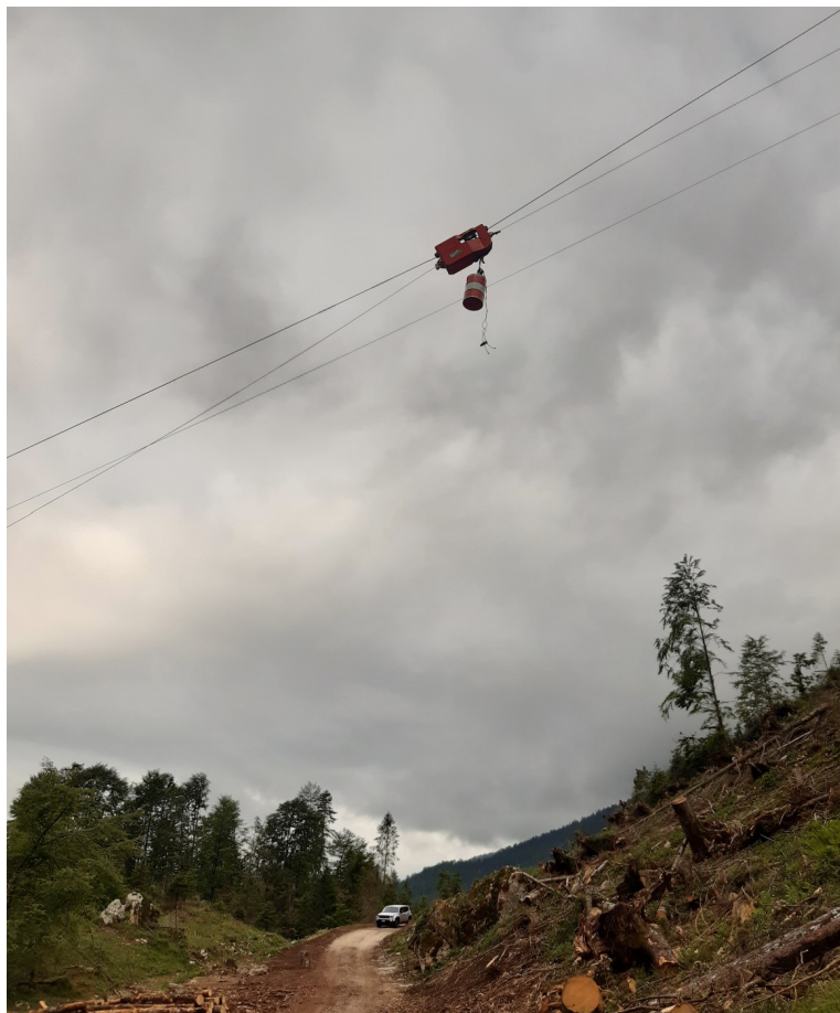
Fig.4.1 Segnalazione presenza linea gru a cavo secondo la Normativa (fonte: Ruggero Alberti – APROFOD).
