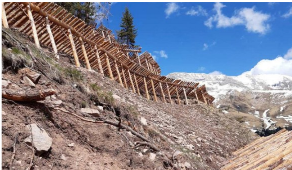
Fig. 9.14 Paravalanghe realizzati sul versante schiantato, tra un paravalanghe e l'altro sono stati realizzati gli impianti (fonte: Andrea Carbonari).
